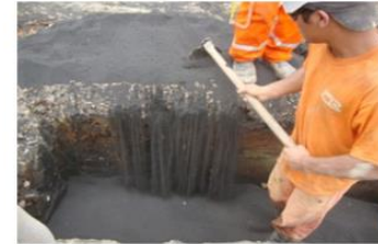
Uso da ADF em assentamento de tubos
